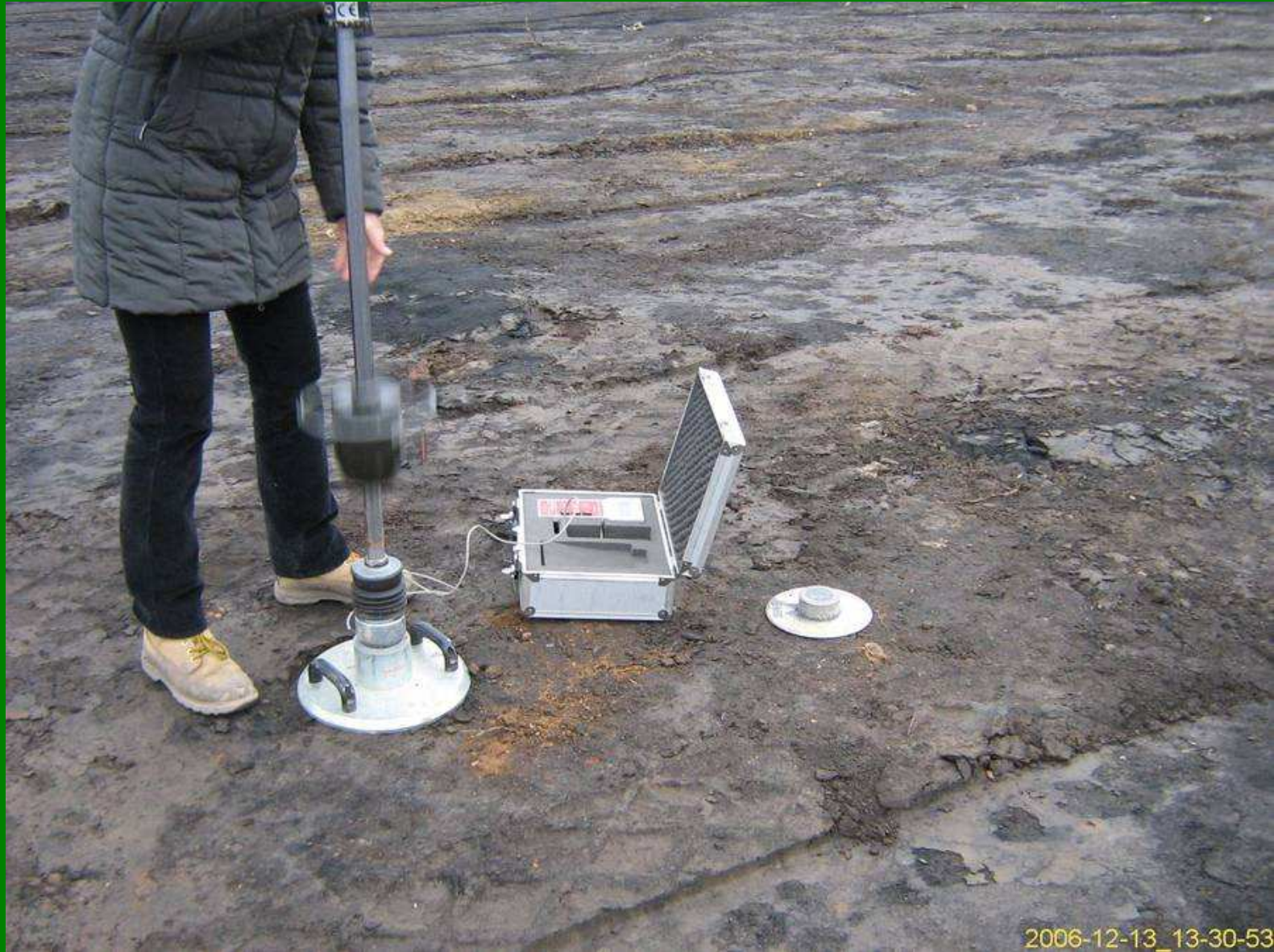
Verdichtungskontrollen im Deponiekörper
