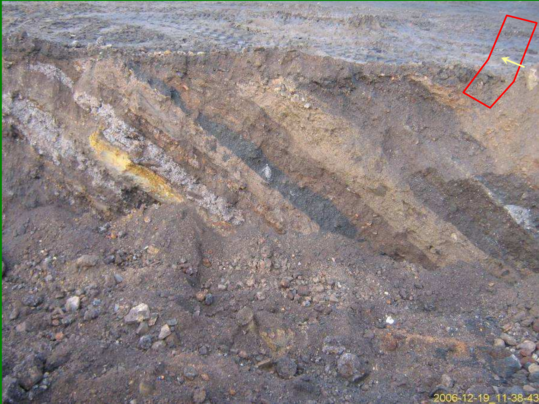
Gewerbegebiet: Detail des Profils früherer Schlackeauffüllungen
