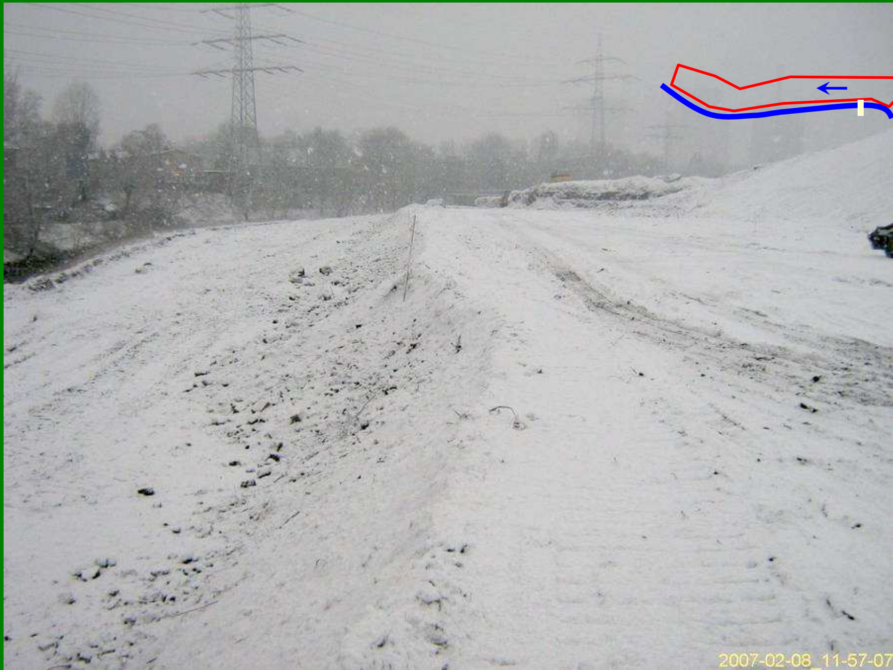
8. Februar 2007: Schnee am Landschaftsbauwerk
