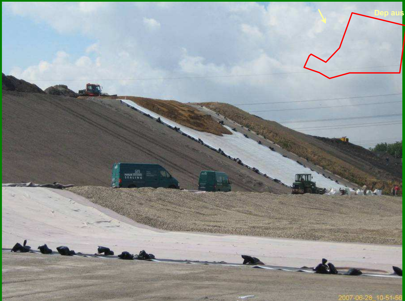
Bau des Probefeldes zum geänderten Aufbau der Rekultivierungsschicht
