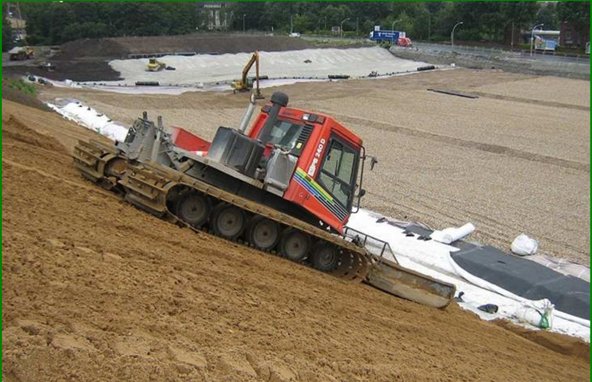
Oberflächenabdichtung: Einbau in den Steilbereichen
