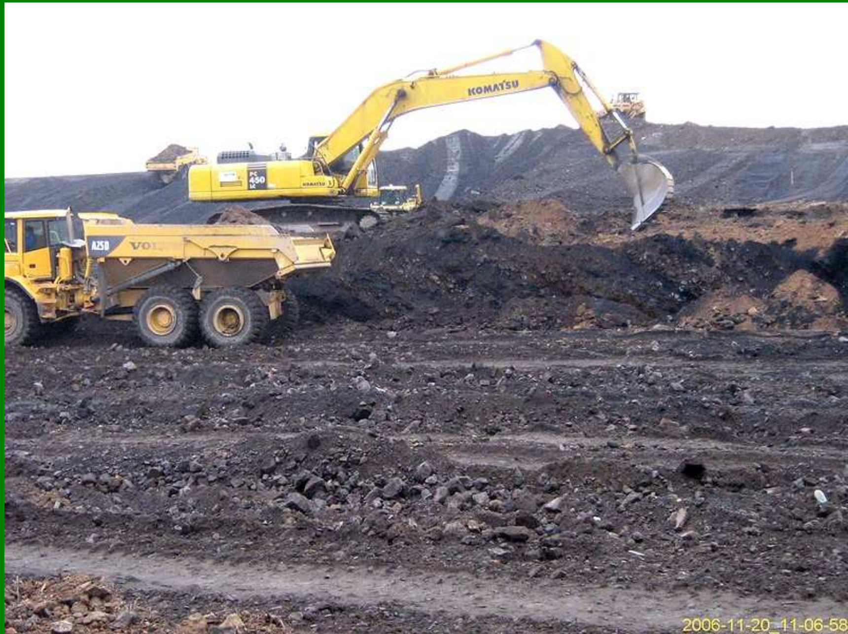
Landschaftsbauwerk: Bau des Deponiekörpers
