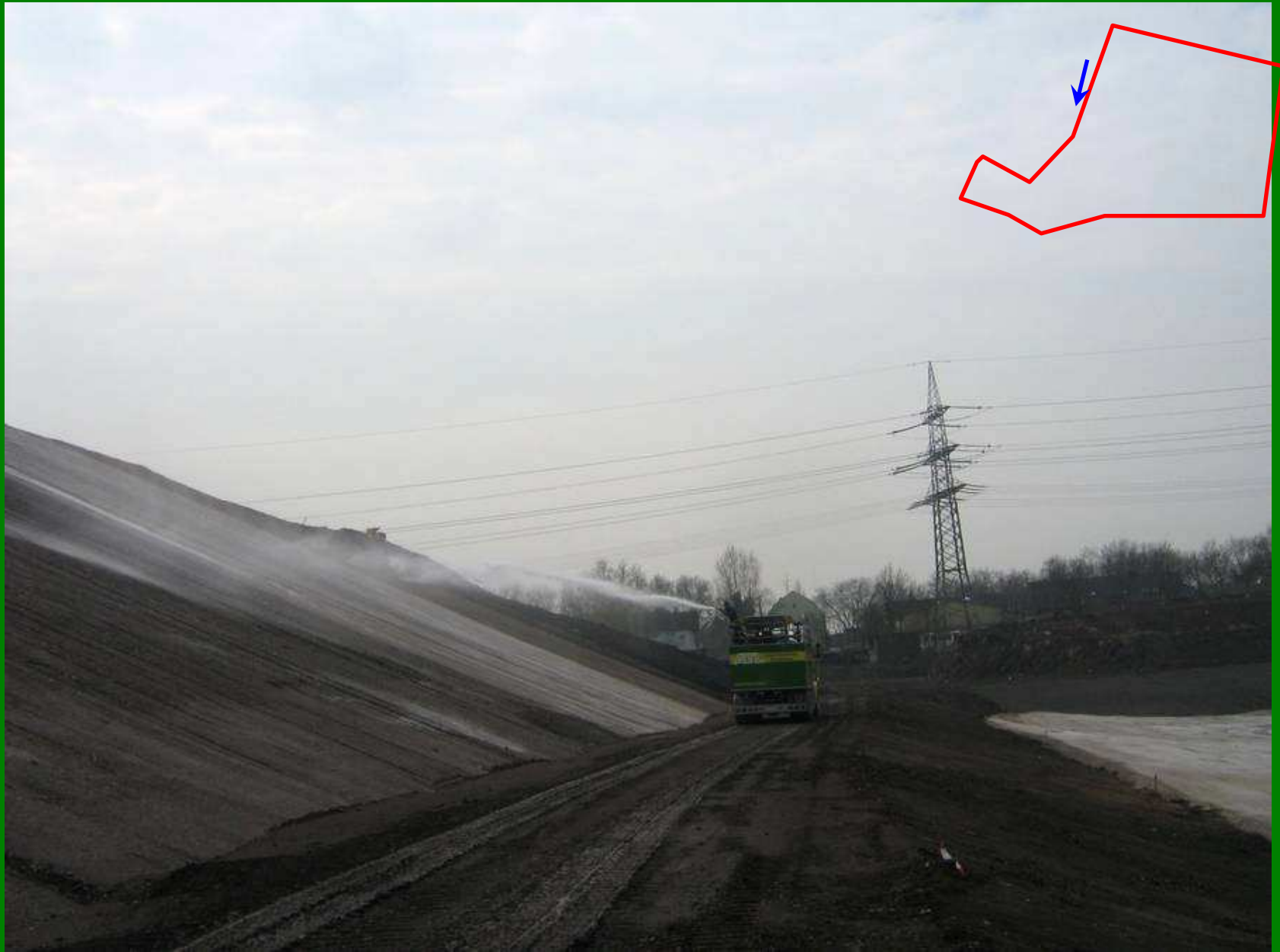
Deponie: Aufbringen von „Terra-Control“ zur Staubbindung
